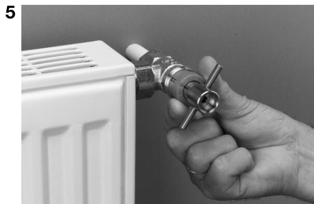
La flèche de la bague de réglage doit être en ligne avec le marquage de la clef de préréglage.
