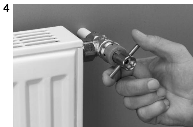
4 Tourner la vis de préréglage à la droite jusqu'à la butée à l'aide de la clef.
