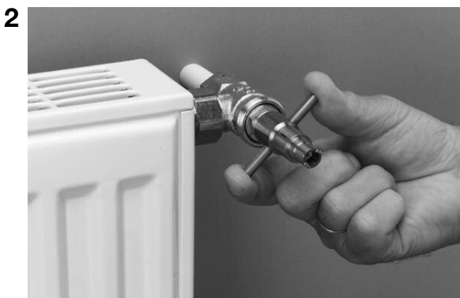
Stopfbuchsschraube herausdrehen (Wasser tritt nicht aus, da das Ventil eine weitere Abdichtung besitzt).
