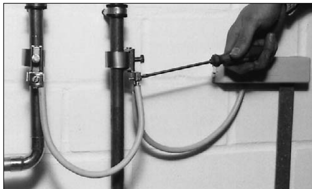
Fig. 9: Pour réaliser la mise à la terre, fixer des bornes de mise à la terre sur les deux tubes du circuit solaire et relier un câble d'au moins 6 mm² au rail principal de compensation de potentiel.
