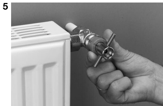
5 La flèche de la bague de réglage doit être en ligne avec le marquage de la clef de pré réglage.
