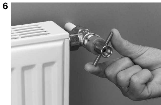
6 Effectuer le pré réglage en tournant vers la gauche (un tour complet correspond à la valeur de pré réglage 1 etc., max. de 6 tours).
