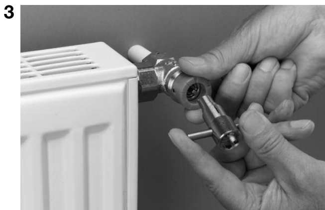
3 Placer la bague de réglage sur le robinet.
