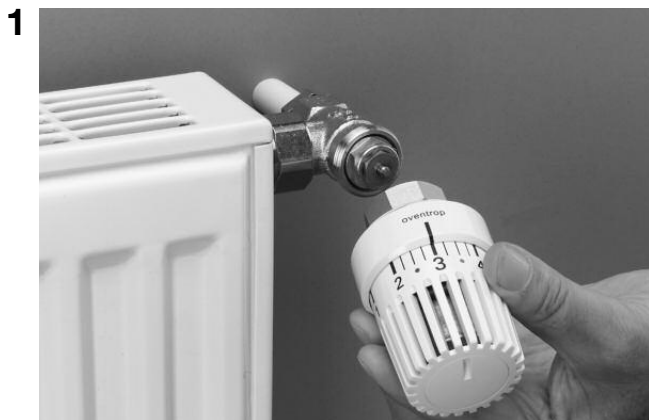
1 Thermostat vom Ventil abschrauben.
