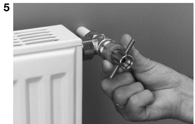
5 Pfeil des Einstellringes auf die Markierung des Voreinstellschlüssels stellen.
