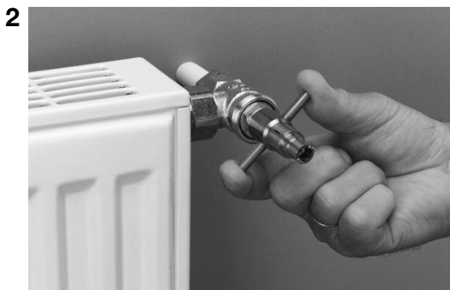
2 Dévisser l'écrou presse-étoupe (grâce à la double étanchéité du robinet, un échappement d'eau est évité).
