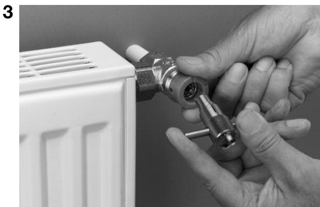
3 Einstellung auf das Ventil stecken.
