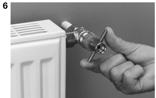
6 Durch Linksdrehen wird die Voreinstellung vorgenommen (eine volle Umdrehung entspricht der Voreinstellung 1 usw., max. 6 Umdrehungen).
