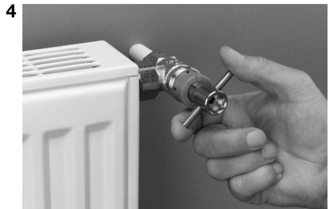
4 Mit dem Schlüssel die Voreinstellschraube durch Rechtsdrehung bis zum Anschlag drehen.
