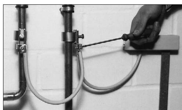
Bild 9: Für Potentialausgleich Erdungsschellen an beiden Solarkreisröhren anbringen und mind. 6 mm<sup>2</sup> Kabel mit Hauptpotentialausgleichsschiene verbinden.
