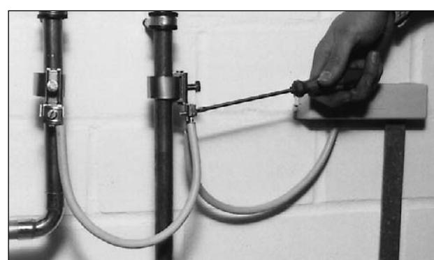
Fig. 9: Pour réaliser la mise à la terre, fixer des bornes de mise à la terre sur les deux tubes du circuit solaire et relier un câble d'au moins 6 mm<sup>2</sup> au rail principal de compensation de potentiel.
