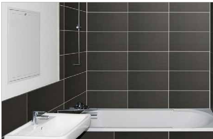
Uitvoering van de installatie (gesloten)
