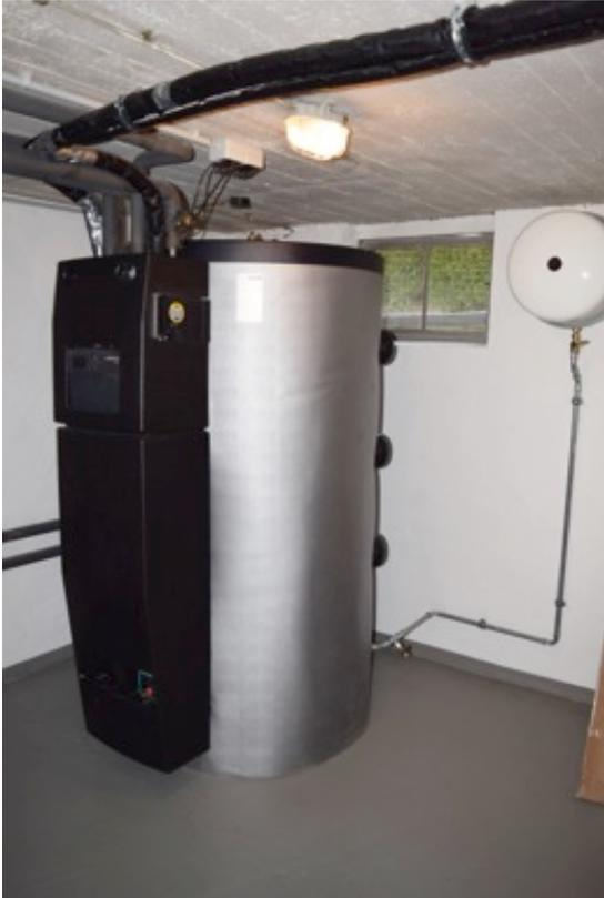
Durch die kompakt aufgebaute Energiespeicher-Zentrale konnte die gesamte Wärme- und Warmwasserversorgung des Hauses in einem kleinen Kellerraum konzentriert werden. Der bisher für die Öl-Tanks benötigte Keller kann jetzt anderweitig verwendet werden.
