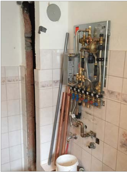
Montage einer „Regudis W“ Wohnungsstation
