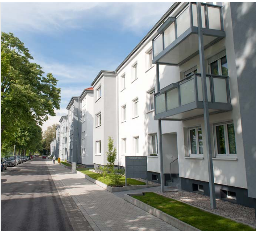
Im Jahr 2014 wurde mit der Sanierung der Gebäude begonnen und im Frühjahr 2017 abgeschlossen
