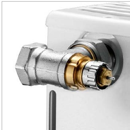
Konventioneller Heizkörper (Abb. Danfoss, Baureihe RA) mit Klemmverbindung
