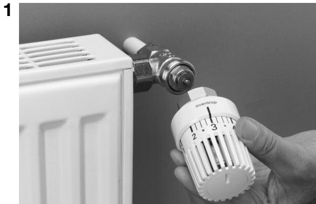
Thermostat vom Ventil abschrauben.
