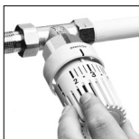
Fig. 6: Montați mânerul astfel încât cifra „3” de pe mâner să se afle în dreptul marcajului de setare.
