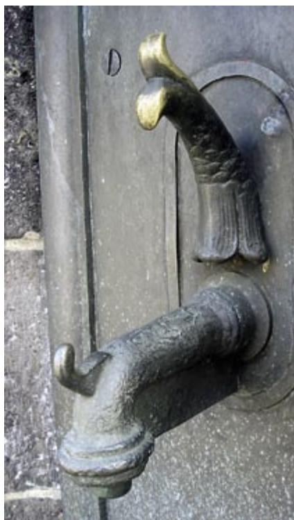
Kran czerpalny z brązu – zdjęcie studni z promenady przybrzeżnej w mieście Düsseldorf
