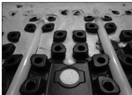
Fig. 1.1 Système de dalles à plots NP-R
