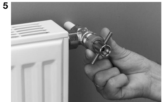
Pfeil des Einstellringes auf die Markierung des Voreinstellschlüssels stellen.
