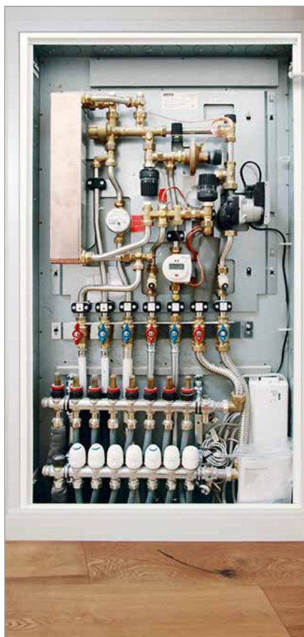
Uitvoering van de installatie
