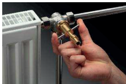
(1) Dépose du cache-écrou à l'aide de l'outil spécifique
