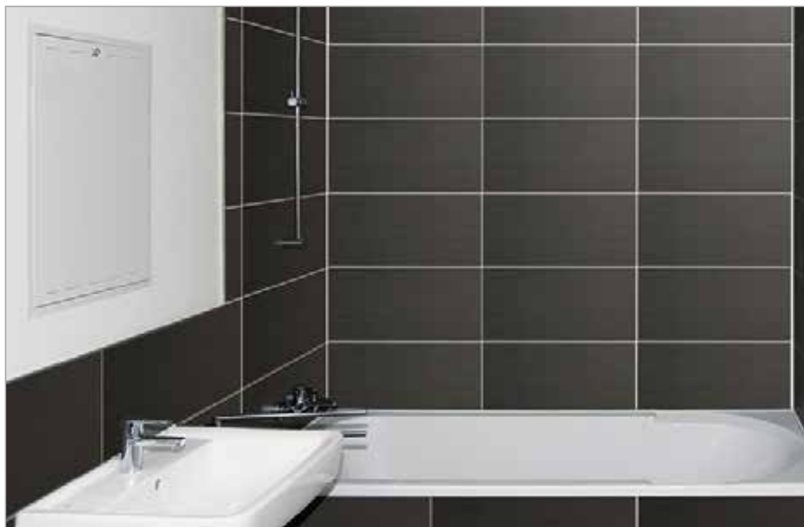
Uitvoering van de installatie (gesloten)
