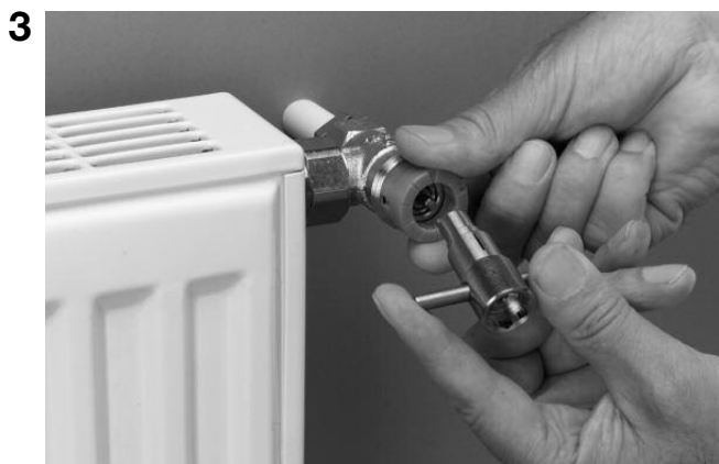
Placer la bague de réglage sur le robinet.
