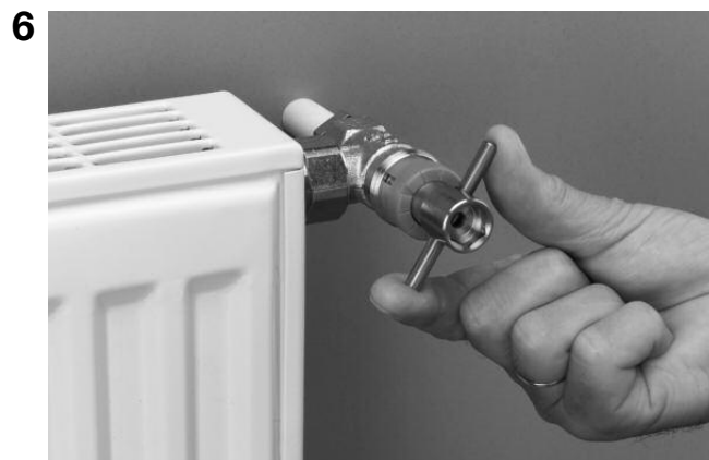
Durch Linksdrehen wird die Voreinstellung vorgenommen (eine volle Umdrehung entspricht der Voreinstellung 1 usw., max. 6 Umdrehungen).
