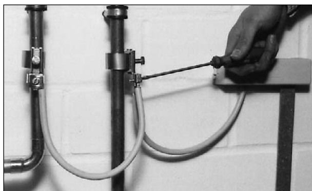
Fig. 9: Pour réaliser la mise à la terre, fixer des bornes de mise à la terre sur les deux tubes du circuit solaire et relier un câble d'au moins 6 mm 2 au rail principal de compensation de potentiel.
