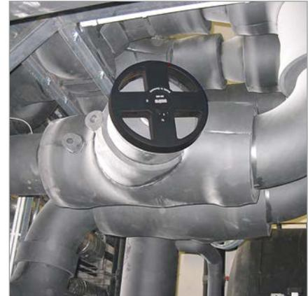
„Hydrocontrol VFC“ Grauguss-Flanschventil, DN 350, als Regelarmatur in Kühlwasserleitungen
