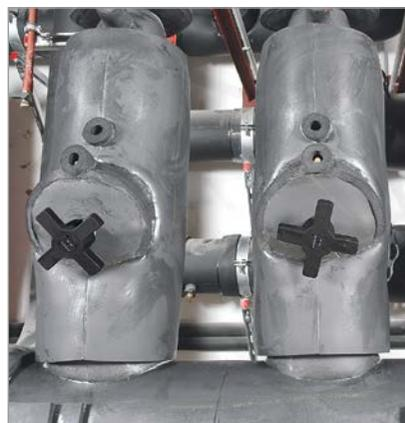
„Hydrocontrol VFC“ Grauguss-Strangregulierventile PN 16, DN 125 und DN 200, in einer Großanlage zum hydraulischen Abgleich von Kaltwasser
