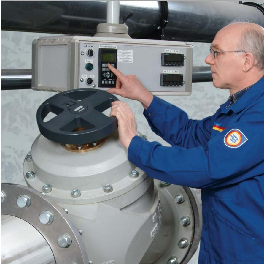
Messen eines „Hydrocontrol VFC“ Grauguss-Flanschventils, DN 350
