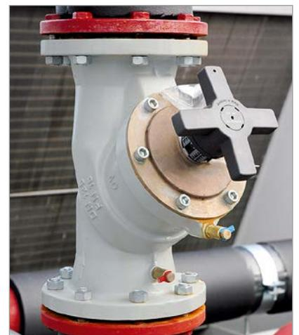
Regulierung und hydraulischer Abgleich von Kühlwasser (Anschluss an Rückkühler einer Dachzentrale) mit „Hydrocontrol VFC“ Grauguss-Strangregulierventil, PN 16, DN 125, vor dem Anbringen der Isolierung und des Witterungsschutzes
