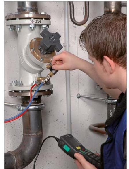
Einregulierung mittels Oventrop Messsystem „OV-DMC 2“
