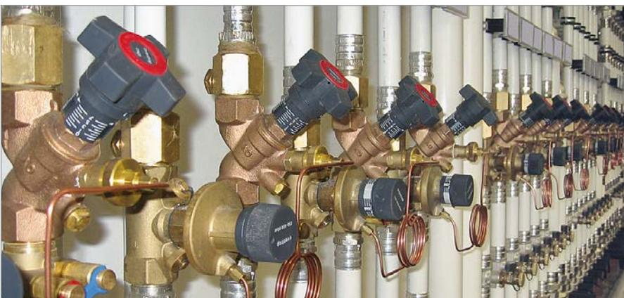
„Hydrocontrol VTR“ Rotguss-Strangregulierventil PN 16 und „Hyocon DTZ“ Differenzdruckregler in einer zentralen Heizwasser-Verteilanlage
