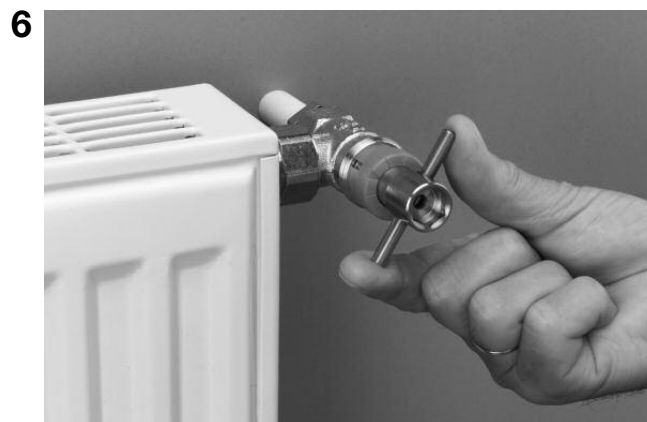
Effectuer le préréglage en tournant vers la gauche (un tour complet correspond à la valeur de préréglage 1 etc., max. de 6 tours).
