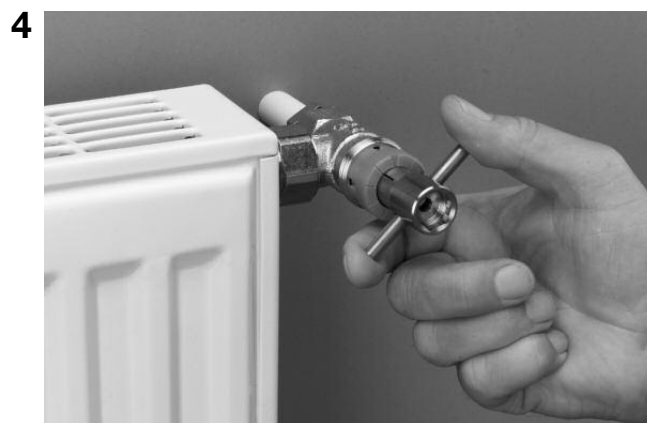
Tourner la vis de préréglage à la droite jusqu'à la butée à l'aide de la clef.
