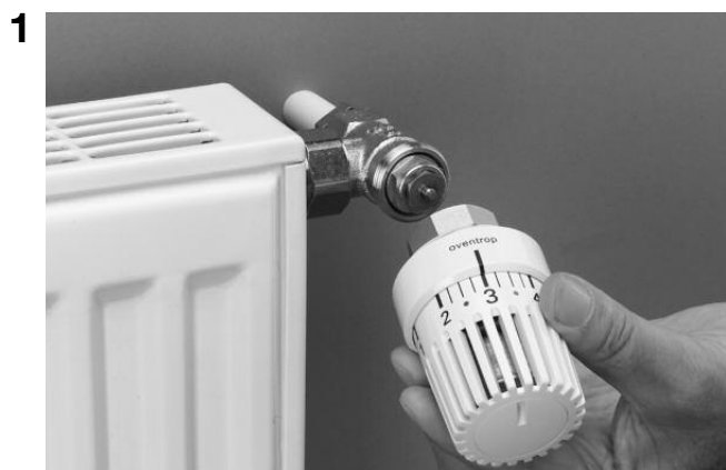
Thermostat vom Ventil abschrauben.
