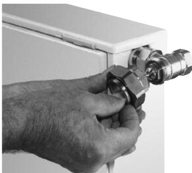
In nicchie e radiatori con coperture, avvitare prima il raccordo del „Demo Bloc“ sulla valvola
