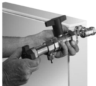
Dopo aver rimosso la testa termostatica dalla valvola, allentare leggermente il vitone (chiave da 19 per M 30 x 1,5 e chiave da 17 per M 30 x 1,0). Poi avvitare il „Demo-Bloc“ sulla valvola.
